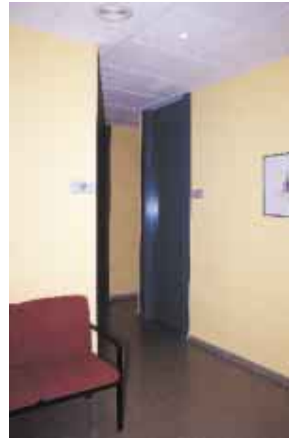
Fig.1. Techo modular apoyado sobre perfiles metálicos.
